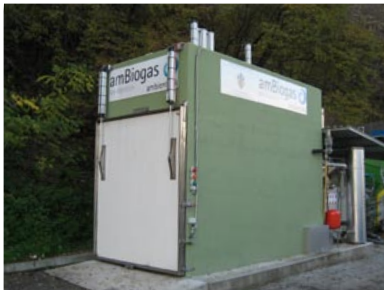
L'impianto con il portellone frontale.
