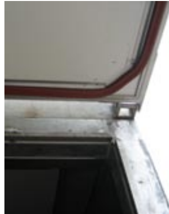
Guarnizione gonfiabile per tenuta stagna.
