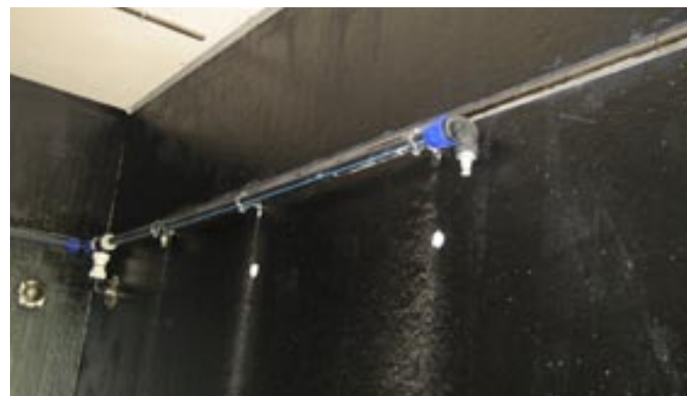
Particolare aspersione percolato
